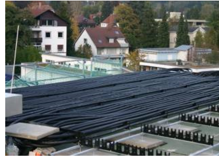
Flachdach- absorber (im Bau)
